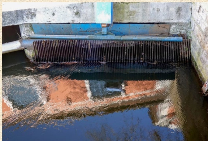
Čistotu vody v Ohři zajišťují na místním jezu česle
